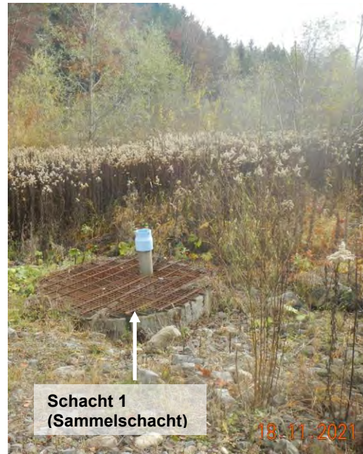
Messstelle Schacht 1 (Sammelschacht – S1)
