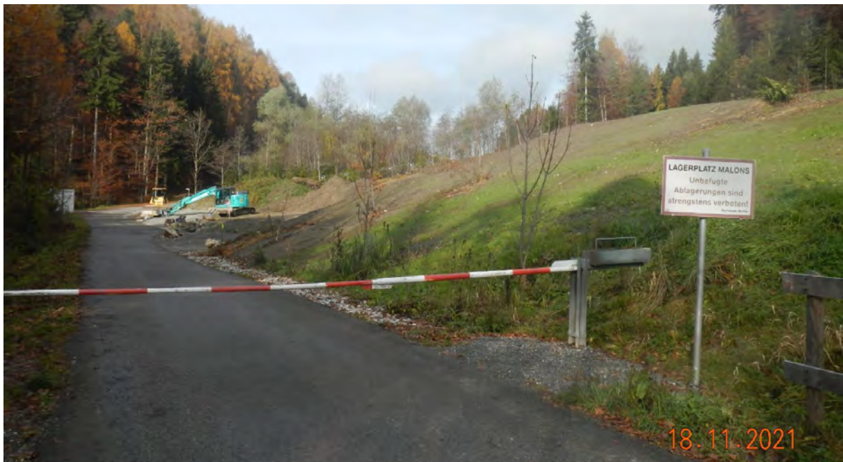
Ansicht Altablagerung bzw. in Betrieb befindliche Bodenaushubdeponie (Zufahrt von Süden)
